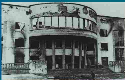
Здание Дворца Культуры имени С. М. Кирова, разрушенное вражескими бомбардировками СССР, Мурманск. 18 июля 1942
